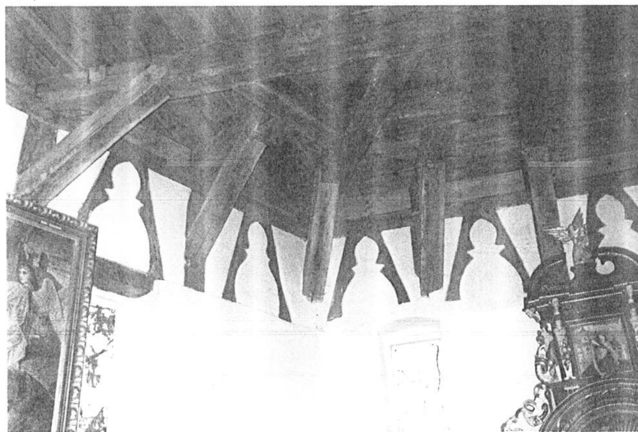
4. Krupy, kościół, wnętrze, widok w kierunku wschodnim. Stan obecny
