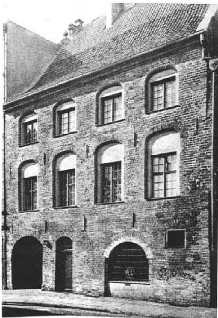
Il. 108 Toruń, ul. Szczytna 11 - pozostawione okna z XVIII w. w fasadzie z k. XVI w. [fot. Cz. Kuchta]
