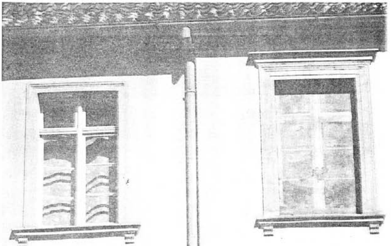
Il. 70 Okno rzeczywiste i malowane z poziomymi szczelinami, pocz. XIX w. Toruń, ul. Jęczmienna 16, I piętro [fot. W. Górski]
