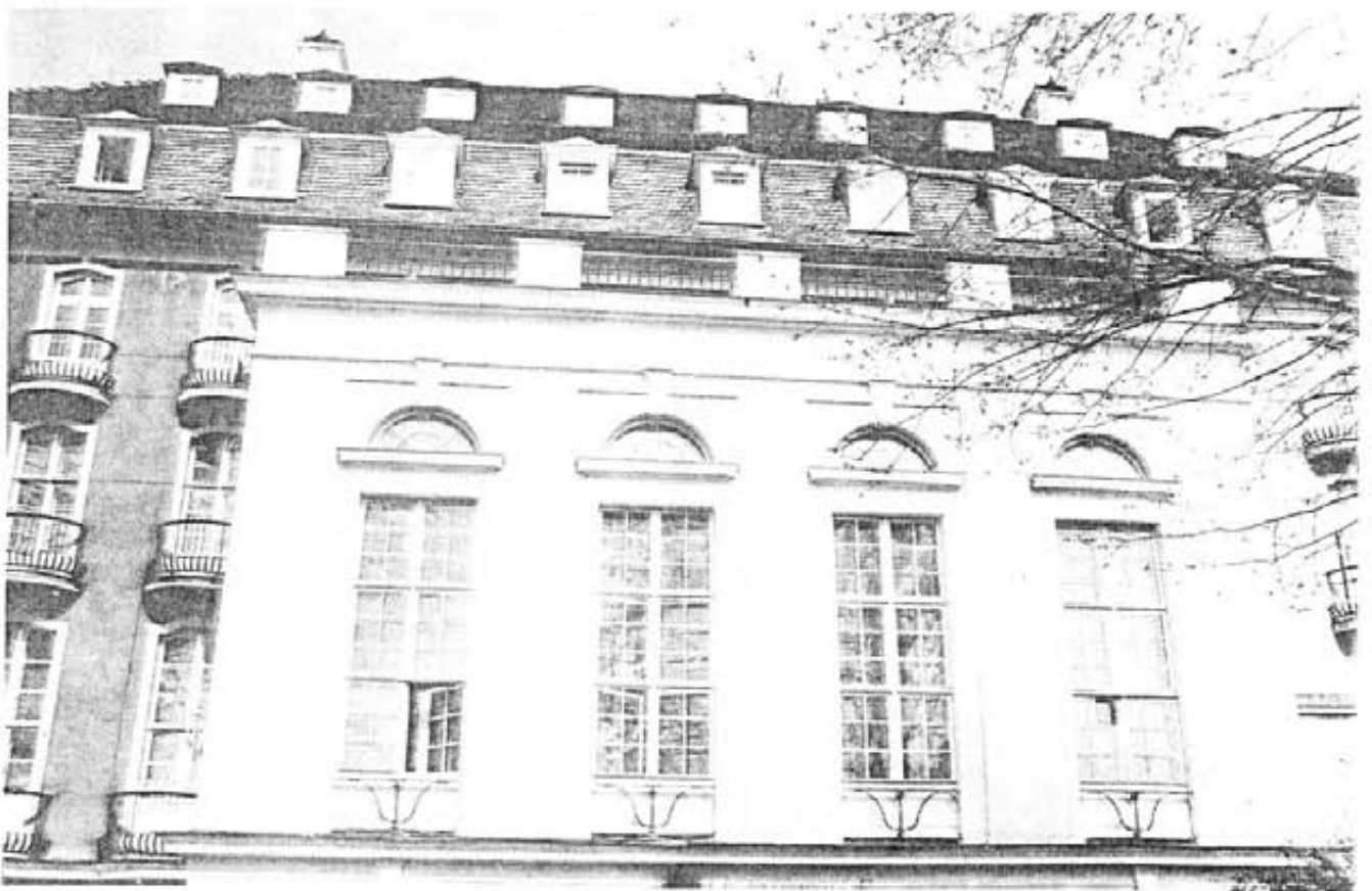
II. 101 Sopot, Grand Hotel (1924-1927), fragment elewacji bocznej z oknami szklonymi w szczelinach krzyżowych i poziomych [fot. T. Chrzanowski]
