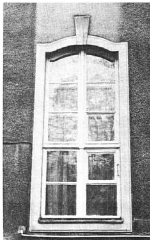
Il. 131 Sopot, Grand Hotel, parter od ulicy. Oryginalne okno skrzynkowe z widocznymi podwójnymi szczelinami i charakterystycznym krzyżem okiennym [fot. T. Chrzanowski]
