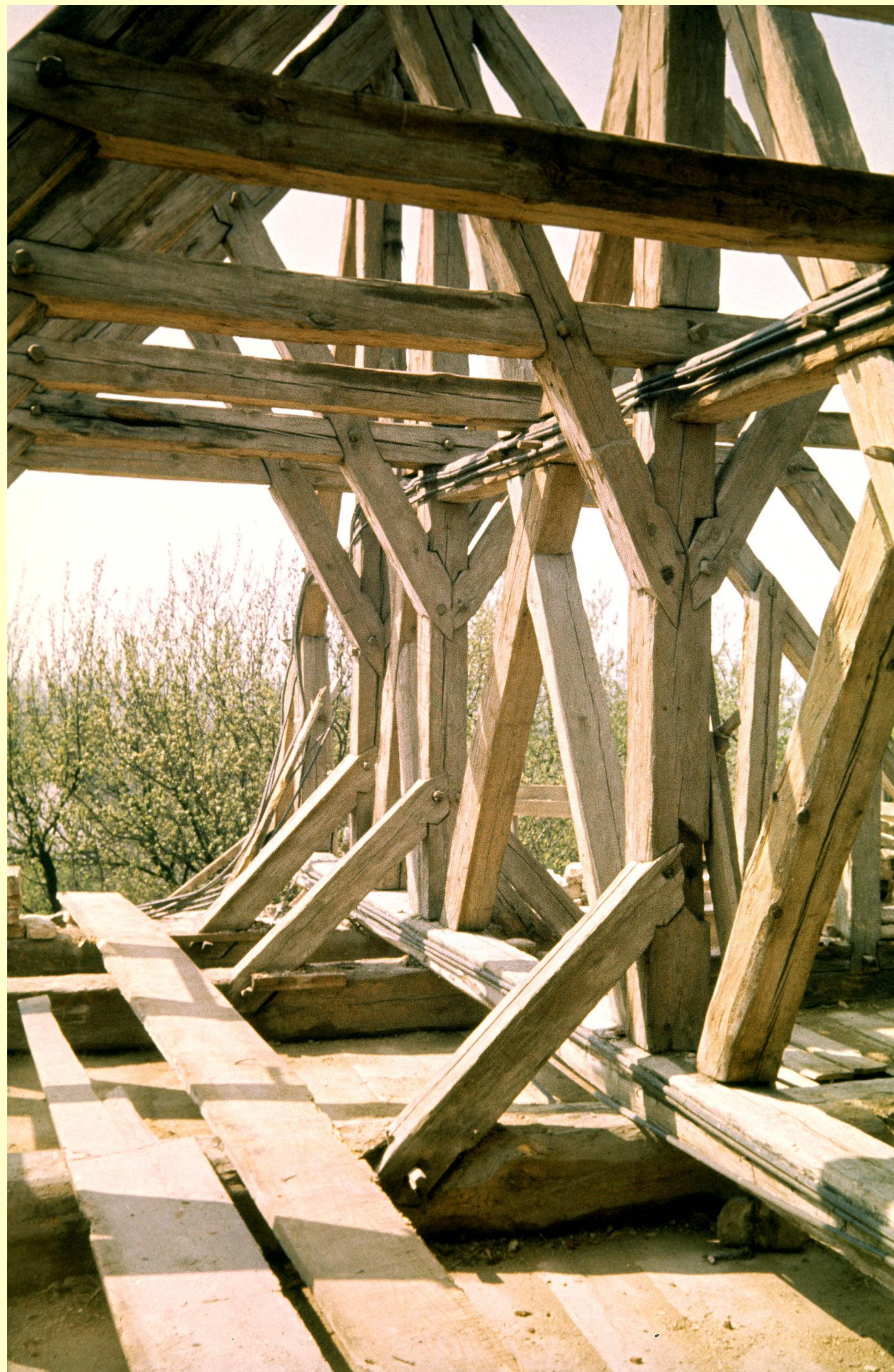
WIĘŻBA STORCZYKOWA Z XV w. NAD PREZBITERIUM KOŚCIOŁA W IZBICY KUJAWSKIEJ fot. J. Tajchman
