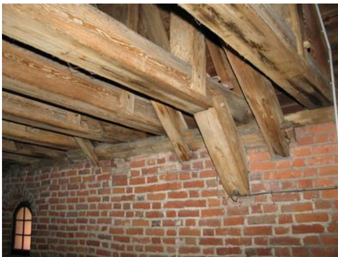
fot.2. Miecz w pn-wsch. części poddasza, wchodzący w ścianę pn.
