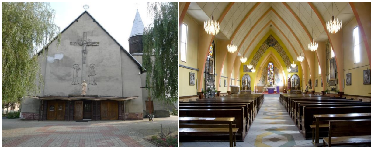
Il. 1. Zabrze, kościół pw. św. Macieja Apostoła, elewacja frontowa i wnętrze, fot. A. Żaba
